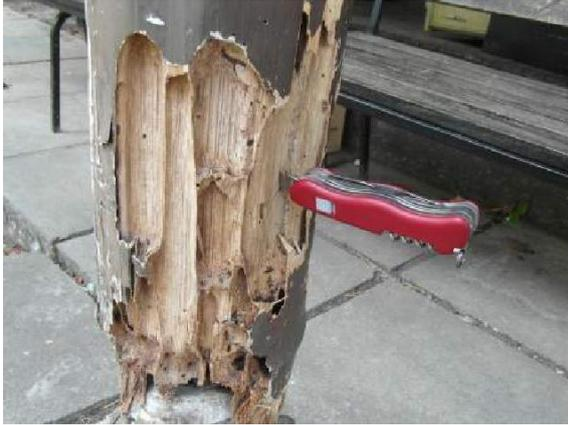
*Figura 34: Daño severo por termitas en bambú, Costa Rica. Tenga en cuenta que la capa exterior de sílice pintada del bambú todavía está intacta en algunas áreas y, por lo tanto, aparece en buenas condiciones (Kaminski, 2016)*
