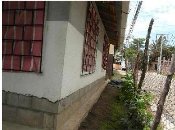
*Figura 27: Vivienda de caña y madera, El Salvador - completa. Tenga en cuenta la parte superior, la membrana a prueba de humedad y el saliente grande, todo lo que protege la pared de la humedad y la lluvia (Kaminski, 2016)*
