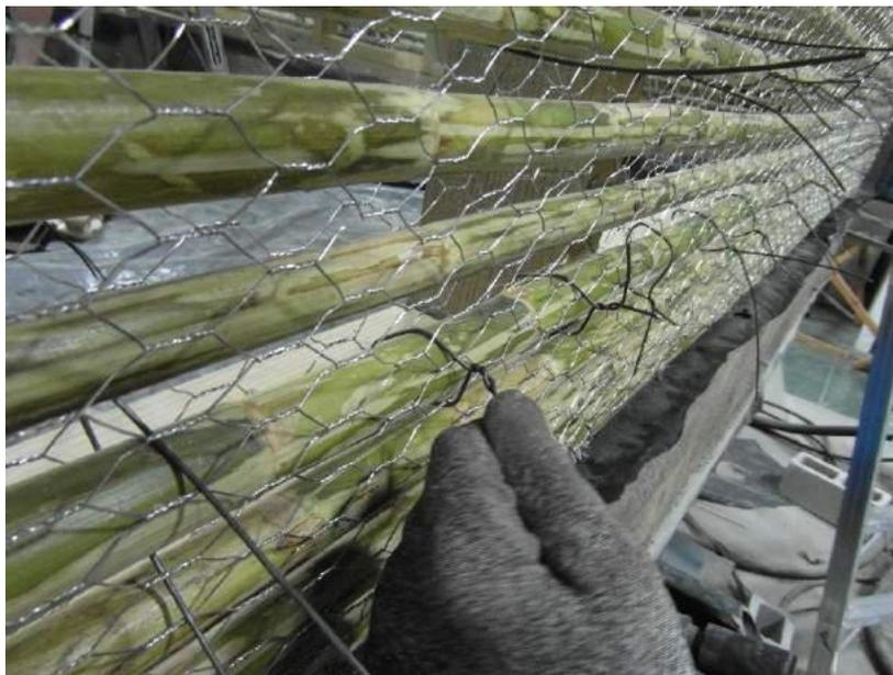
*Figura 72: Instalación de ataduras de alambre de acero para conectar malla de pollo en ambos lados de la matriz*
