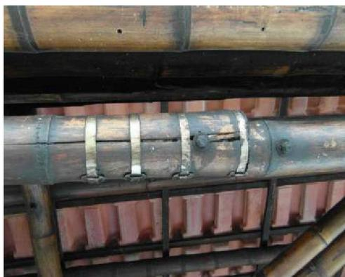
*Figura 73: Lazos de tubería de acero utilizados para fortalecer el bambú después de haber escupido, Colombia (Kaminski, 2016)*
