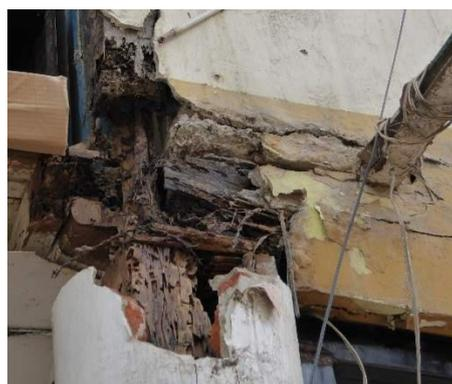
*Figura 47: Daño por putrefacción de la madera en viviendas tradicionales de bahareque, Ecuador (Kaminski, 2016)*
