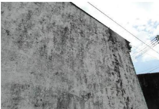
*Figura 42: Casa de bahareque encementado a en Colombia sin voladizo del techo: el molde en la pared es claramente visible (Kaminski, 2016)*
