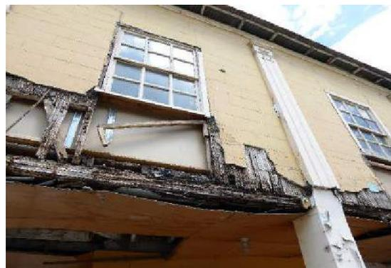
*Figura 43: Daño por putrefacción (y posiblemente termitas) en viviendas de bahareque tradicionales, Ecuador (Kaminski, 2016)..*
