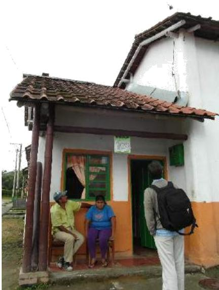
Figura 22: viviendas Bahareque construidas después del terremoto en Barcelona, cerca de Armenia (Kaminski, 2016)
