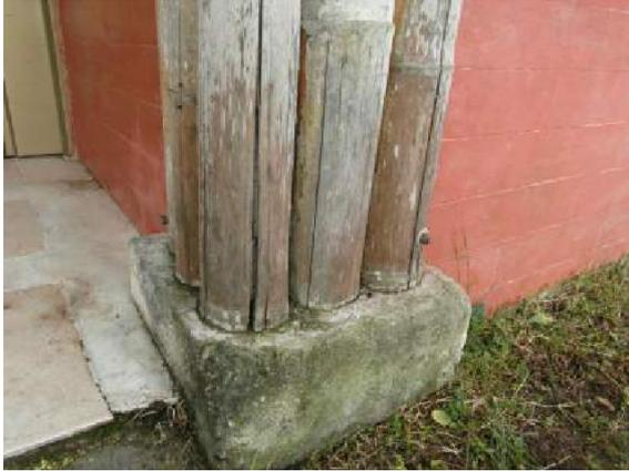
*Figura 38: Daño fúngico, división y decoloración del bambú tratado con boro expuesto al sol y la lluvia después de unos 10 años, Colombia (Kaminski, 2016)*
