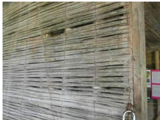
*Figura 7: Esterilla (Colombia) o caña picada (Ecuador): láminas de bambú formadas por la apertura / división física de un culmo de gran diámetro a lo largo y luego desenrollado (Kaminski, 2016)*
