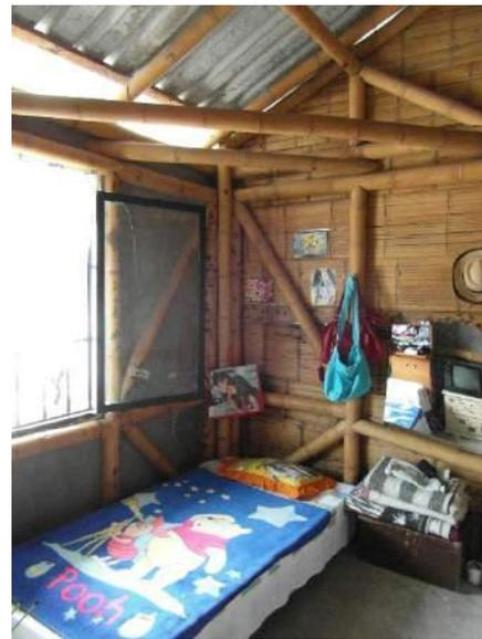
Figura 23: viviendas Bahareque construidas después del terremoto en Montenegro, cerca de Armenia (Kaminski, 2016)
