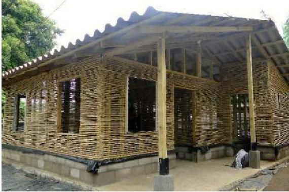
*Figura 24: Vivienda de caña y madera, El Salvador - antes de la aplicación del render. Tenga en cuenta los grandes voladizos en todos los lados y el marco elevado en una membrana a prueba de humedad (Kaminski, 2016)*
