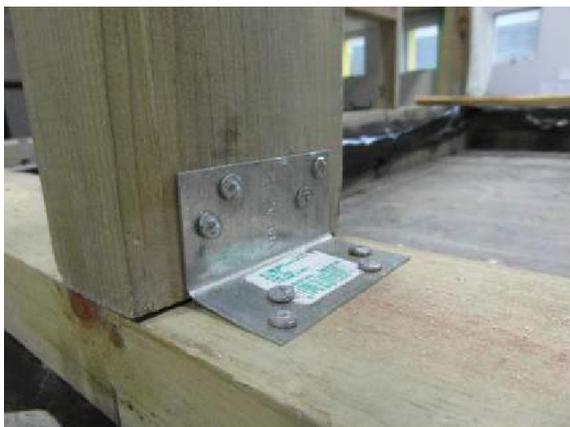
Figura 66: Foto del ángulo de acero utilizado para reparar el perno de madera a la suela
