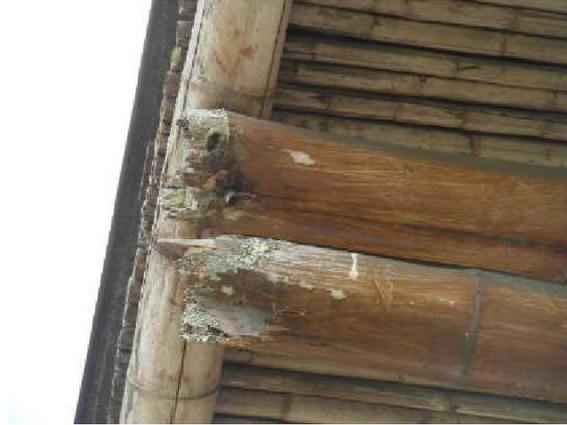
*Figura 39: Rotura al extremo expuesto del bambú en un techo, Costa Rica (Kaminski, 2016)*
