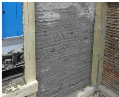
*Figura 74: Mantenimiento de una buena unión entre capas subsiguientes de mortero de cemento mediante la rugosidad de la capa anterior mientras se fija (Kaminski, 2016)*
