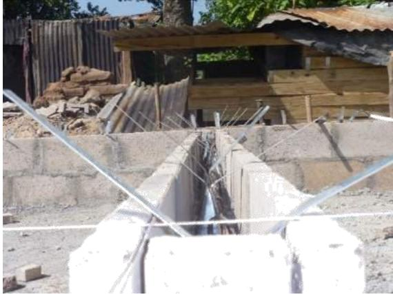
Figura 64: Foto de la suela fija al soporte con correas de acero empotradas, antes de colocar las correas en bloques reforzados
