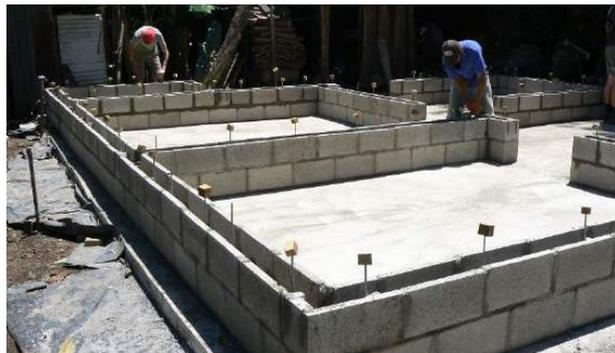
*Figura 60: Ejemplo de soporte vertical simple de viviendas de bahareque encementado en El Salvador, que consta de dos cursos de bloques reforzados, con un total de 400 mm de altura desde la base*
