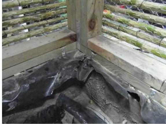
*Figura 70: Detalle de "cuñas" largas de madera colocadas entre los postes de madera, para proporcionar una trayectoria de carga en el plano para las cargas de corte dentro de la pared de corte Bahareque.*
