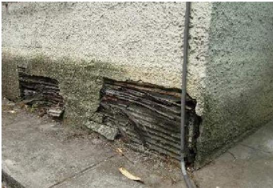
*Figura 40: pérdida de 100% de la sección de la caña en la base de las paredes, Costa Rica. Tenga en cuenta el molde visible en la base de las paredes debido a la salpicadura del techo. El cemento y la pintura claramente no son suficiente protección bajo la lluvia torrencial (Kaminski, 2016)*
