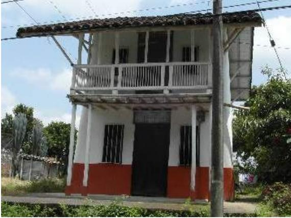
Figura 20: viviendas Bahareque construidas después del terremoto en Montenegro, cerca de Armenia (Kaminski, 2016)
