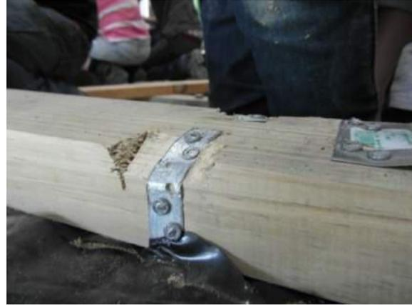
Figura 65: Foto de la suela fijada al soporte con correas de acero empotradas, después de clavar
