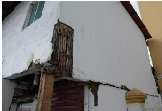
*Figura 41: Depuración del renderizado después del terremoto, revelando la esterilla de bambú podrida a continuación, Ecuador (Kaminski, 2016)*
