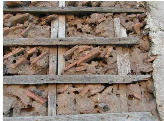
*Figura 11: Primer plano del material de relleno utilizado en el bahareque tradicional sólido en El Salvador - tenga en cuenta las piezas de tejas de arcilla añadidas al suelo (Kaminski, 2016)*
